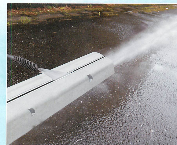
高圧洗浄機による清掃状況
