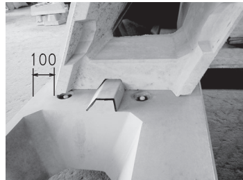
※基礎ブロック上段の突起の斜面が緩やかな方がブロック前面になります。
